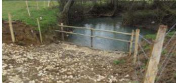
L'aménagement consistait, après un débroussaillage préalable, en la pose de clôtures, placées à 2 mètres du sommet de la berge, sur un linéaire de 5 274 mètres, d'abreuvoirs et de pompes de prairie boulonnées sur un socle en béton.
